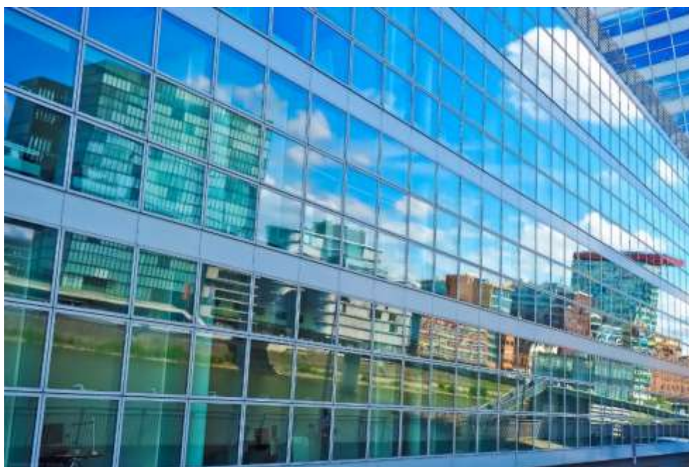
Figura 38: Edifício com fachadas solares fotovoltaicas (fonte: Arcplan).
