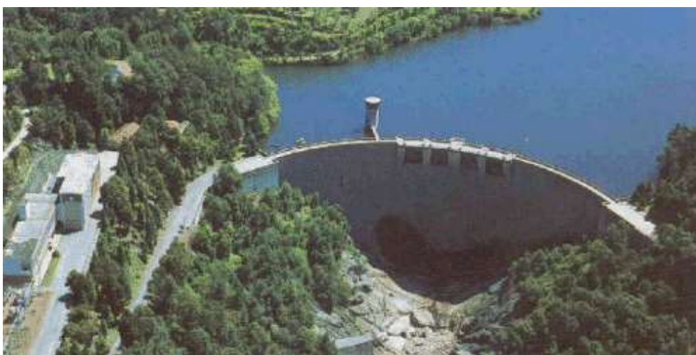
Figura 37. Central hidroelétrica de albufeira, Caniçada (fonte: SNIRH 3 ).
