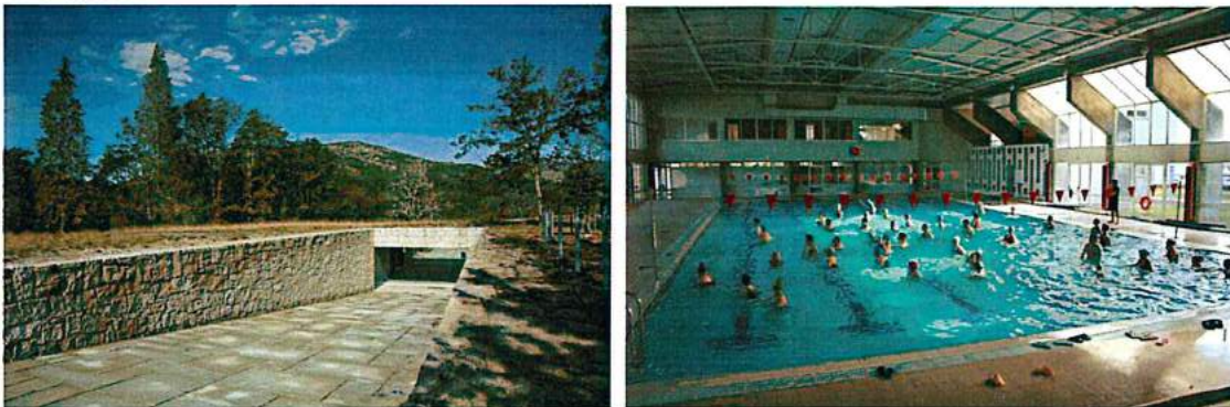
Ilustração 6 – Exemplos de edifícios públicos a monitorizar
